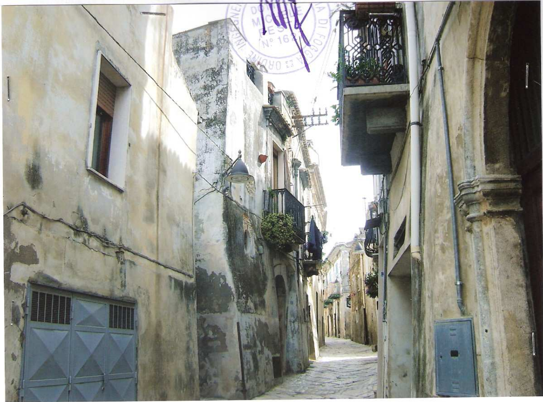
Foto n° 1 - LOTTO UNICO : Particolare prospetto immobile pignorato, visto da via S. Antonio Abate – Serracapriola (FG).
