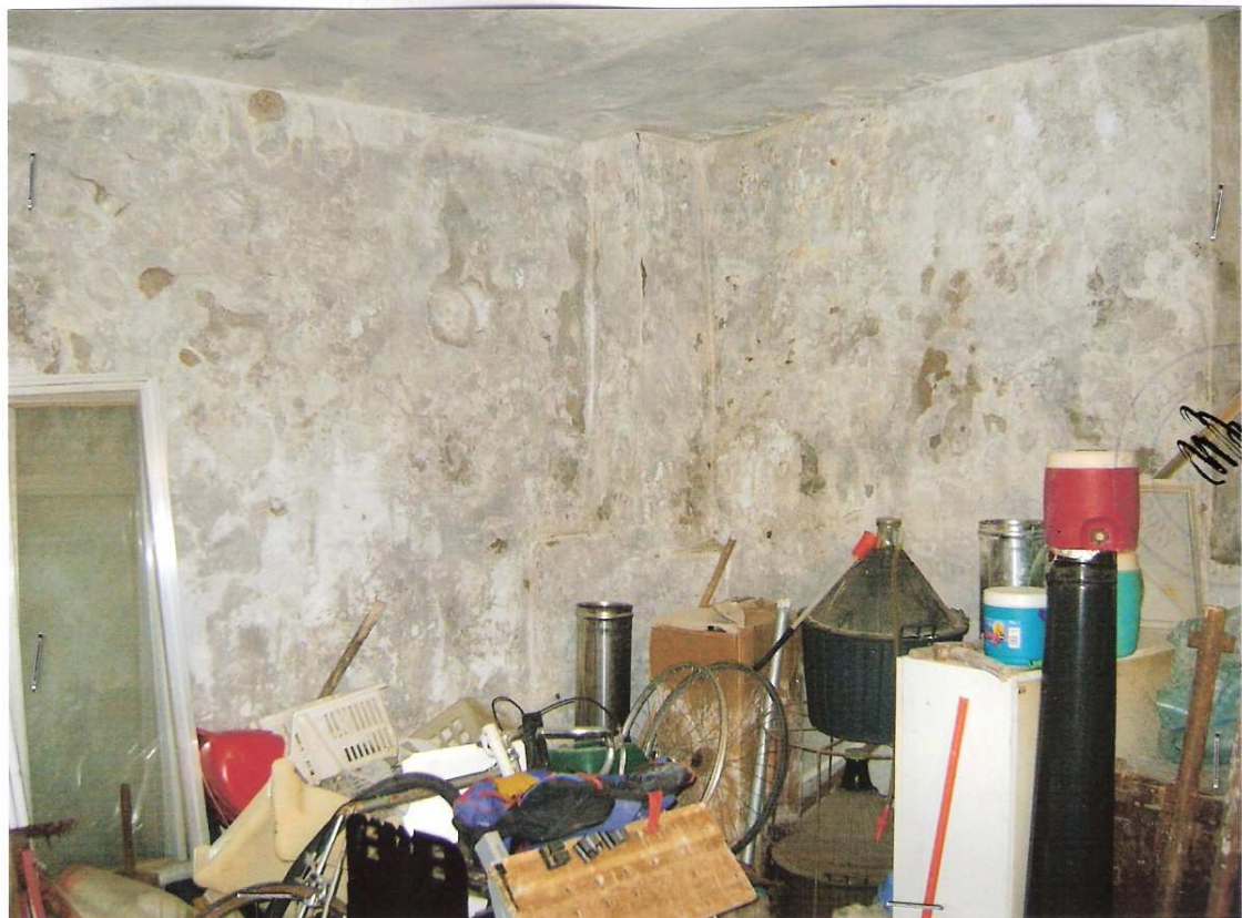
Foto n° 14 - LOTTO UNICO : Particolare rifiniture interne dell'immobile pignorato, cantinola a piano interrato – Serracapiola (FG).
