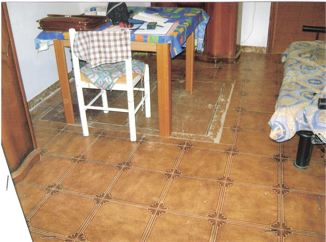
Foto n° 10 - LOTTO UNICO : Particolare rifiniture interne dell'immobile pignorato, botola ingresso cantinola civico n. 10 via S. Antonio Abate – Serracapriola (FG).
