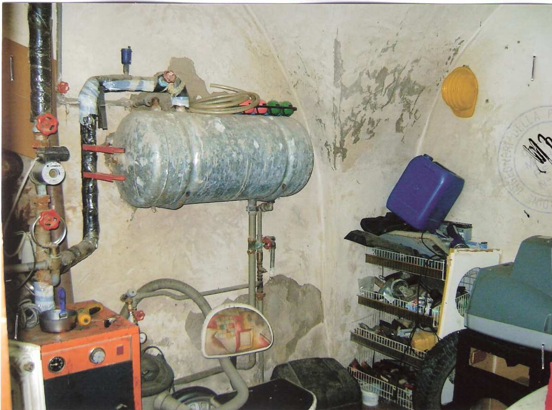
Foto n° 17 - LOTTO UNICO : Particolare rifiniture interne dell'immobile pignorato, civico n. 8 P.T., via S. Antonio Abate – Serracapriola (FG).
