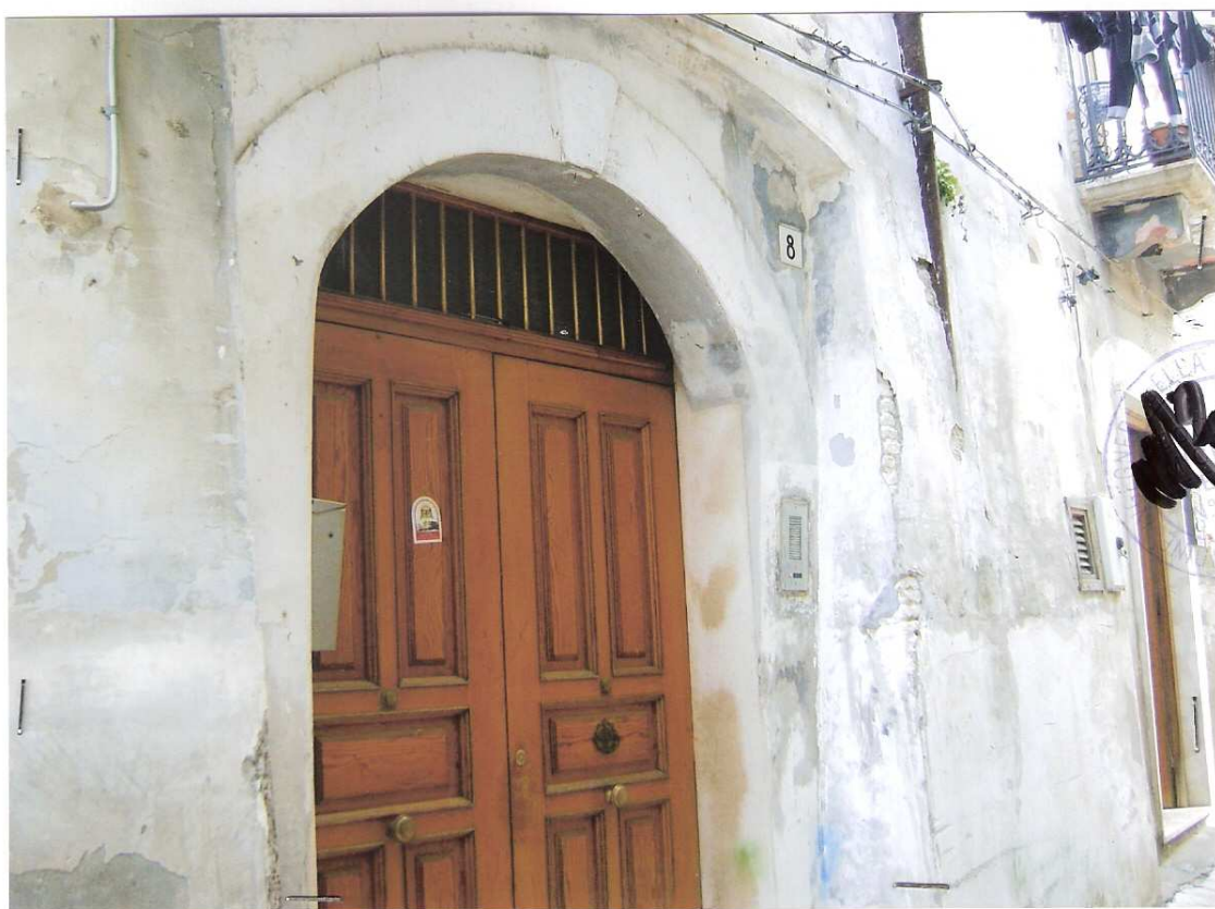
Foto n° 4 - LOTTO UNICO : Particolare ingresso dell'immobile pignorato, civico n. 8 via S. Antonio Abate – Serracapriola (FG).
