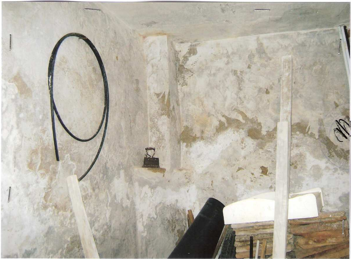
Foto n° 13 - LOTTO UNICO : Particolare rifiniture interne dell'immobile pignorato, cantinola a piano interrato – Serracapiola (FG).
