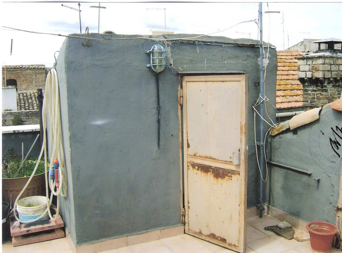
Foto n° 23 - LOTTO UNICO : Particolare rifiniture interne dell'immobile pignorato, civico n. 8 P.copertura, via S. Antonio Abate – Serracapriola (FG).
